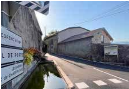
Rénovation du réseau d'eau potable, séparation des réseaux humides d'évacuation avec réfection de l'enrobé.
