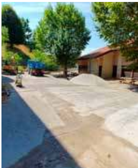
Réfection des réseaux d'eaux usées et d'eaux pluviales.
