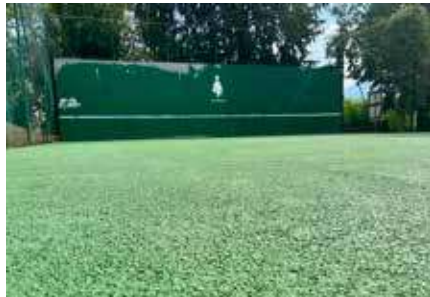
Reprise du sol du mur de frappe.
