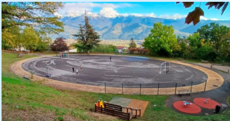
Le plateau sportif avant travaux.
